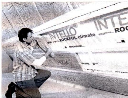
Immobilienbesitzer müssen nicht von vornherein den kompletten Dachstuhl isolieren. Wird der begehbare Speicher nicht als Wohnraum genutzt, genügt das Abschichten der obersten Geschosdecke mit Dämmwolle. Foto: dpa
